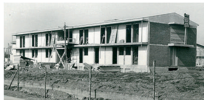
Una foto della costruzione della clinica nel 1955 (archivio Libertà)
